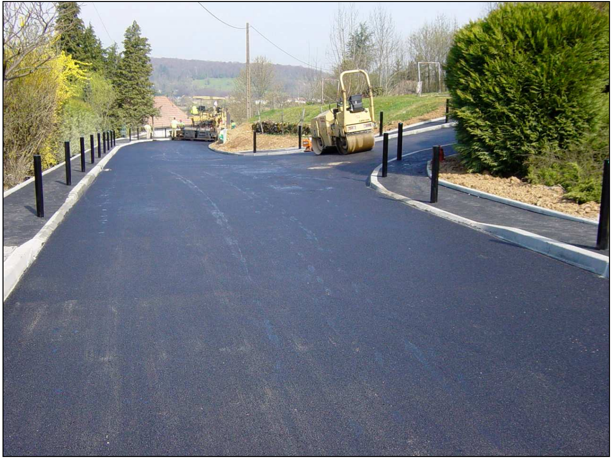
Travaux de pose des enrobés, rue René Paillard, les 27 et 28 mars. Le carrefour de la rue de l'École.
