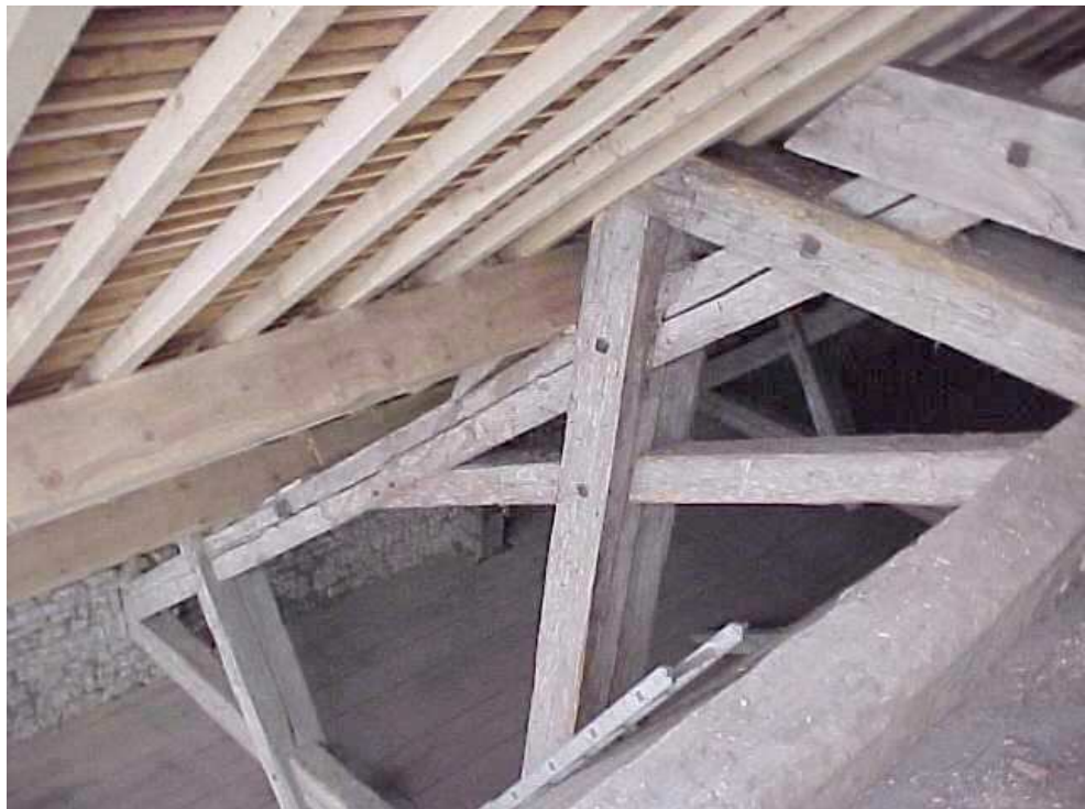
Petite visite guidée à l'intérieur de la charpente de l'église.
